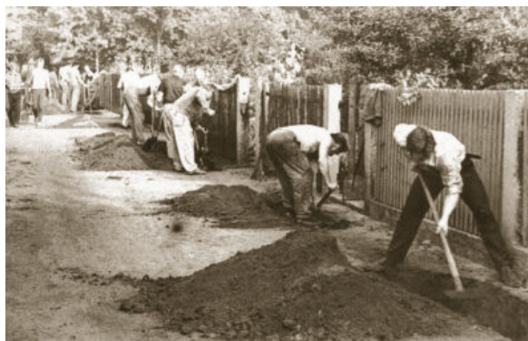
Arbeitseinsatz Wasserleitung Adlerweg, 1993
